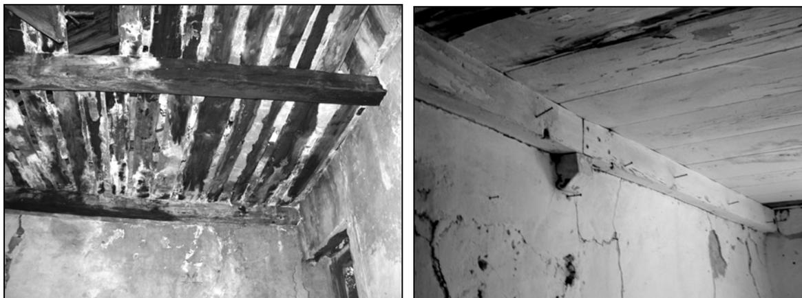
**Ci-dessus. A gauche : plancher soutenant un étage de comble dans une maison du Serre. Les planches reposent sur les poutres équarries, les entrevous étaient remplis au plâtre. A droite : solives jointives dans une maison du quartier du Serre.**
