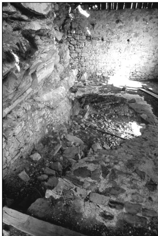
**Ci-contre. Vestiges d'une voûte d'arêtes dans un bâtiment d'exploitation agricole du Serre.**
