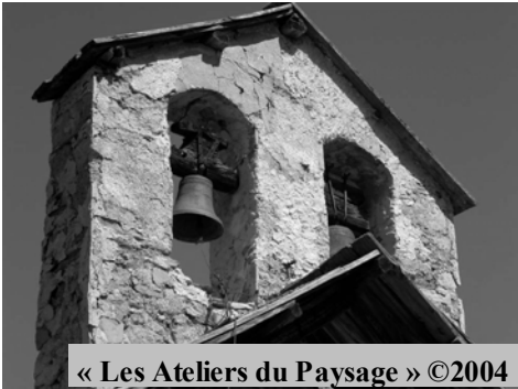
Traces de mortiers et enduits successifs cliché B3019 044
