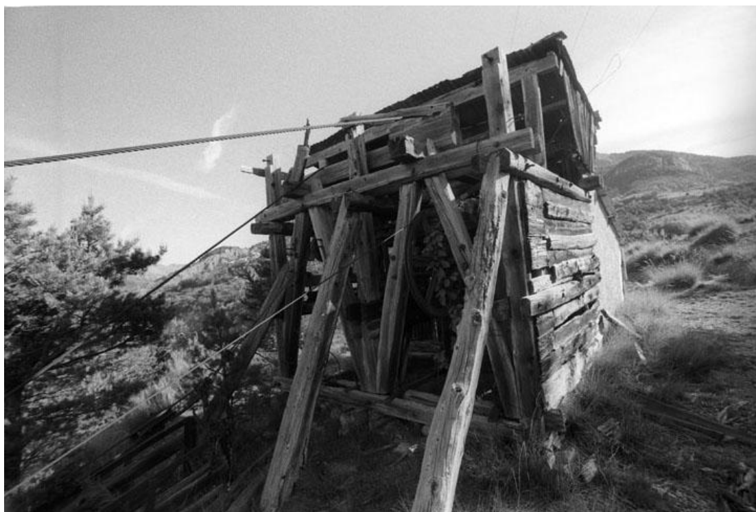
Station du départ du câble à lait Croix d'Empeyron (Bouchannières) G.Véran ©E.P.R
